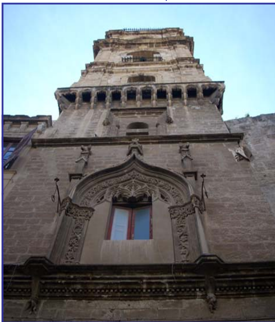
Palazzo Marchesi, torre
