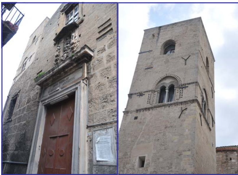
Chiesa di S. Nicolò all'Albergheria e la torre
